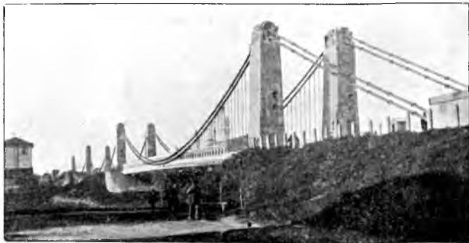
Мостъ на Варшавскомъ шоссе въ г. Островѣ.
