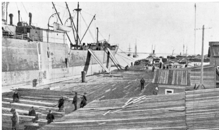
Погрузка пиломатериалов на пристани Кемского лесозавода. Из кн. «Очерк постройки Мурманской железной дороги». Пг., 1917
