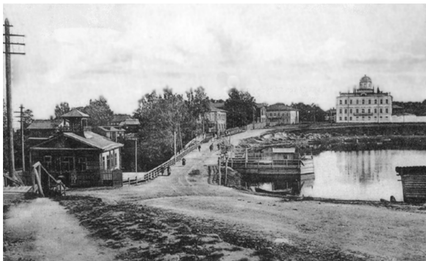
Здание и плотина Петрозаводской ГЭС. Справа — корпус Епархиального училища (до 1902 г. — дом купцов Пименовых). Фото 1910-х гг. Из кн. «История Петрозаводска: власть и горожане» . Петрозаводск, 2008
